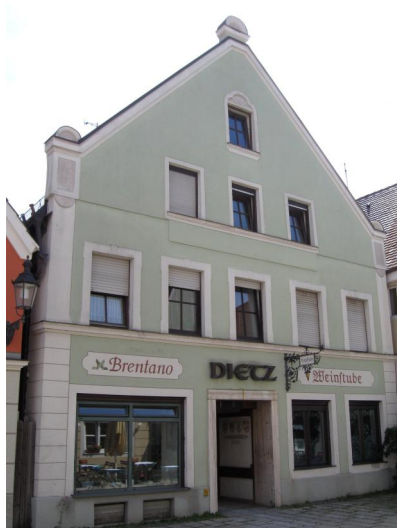
Mindelheim, Kornstraße 18, ehem. Unterkunft und Zentrum jüdischer DPs (Aufnahme 2012). Copyright Wikimedia Commons / Rufus46
