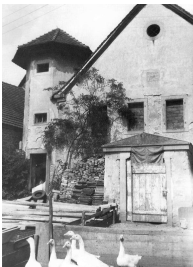
Rimpar, ehem. Synagoge mit vermauerten Fenstern, im Vordergrund ein Gänsestall (Aufnahme wohl um 1941). Copyright WürzburgWiki - Public Domain
