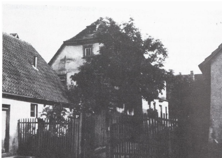
Die ehemalige Synagoge in Bischwind vor dem Abbruch des Gebäudes um 1960. Copyright Mößlein, Longin / Fuchs, Christel: 1200 Jahre Bischwind: 791-1991, Dingolshausen 1991, S. 208
