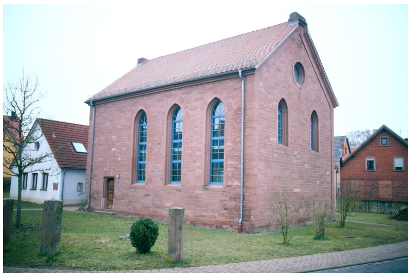
Die ehemalige Synagoge Wiesenfeld nach Abschluss der Restaurierungen 1993. Copyright Hans-Christoph Dittscheid, Maxhütte-Haidhof
