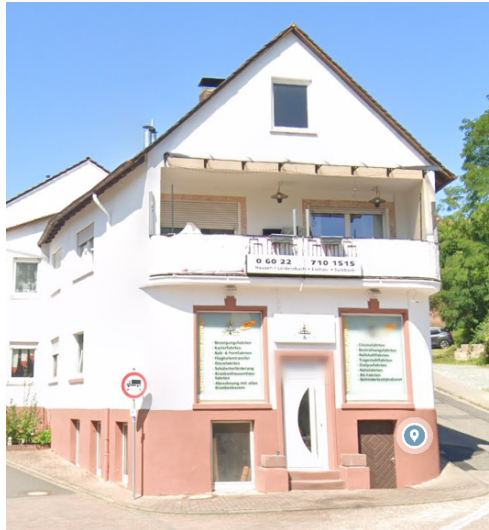
Hausen, Dornauer Weg 1, ehem. Synagoge (Aufnahme 2023). Copyright Google Maps
