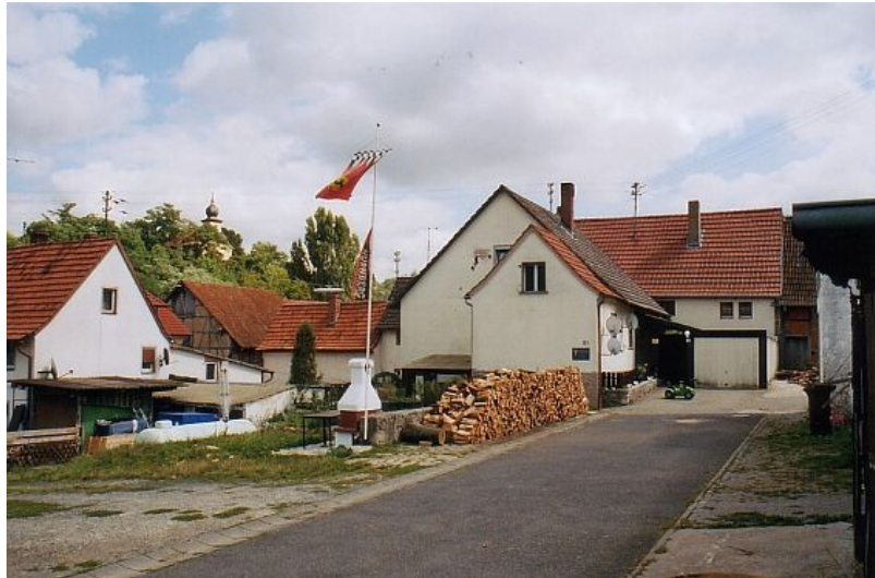
Oberwaldbehrungen, Posthof, auf den Grundmauern der ehemaligen Synagoge steht ein kleines Wohnhaus (Aufnahme um 2015). Copyright Sammlung Reinhold Albert, Sulzdorf an der Lederhecke
