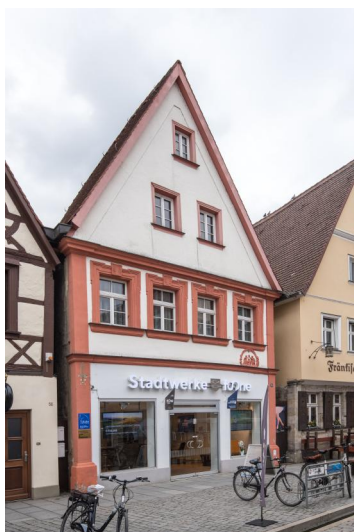
Ehemaliges jüdisches Wohnhaus, Hauptstr. 54, sogenanntes Unteres Judenhaus, seit ca. 1660 Färberei, zweigeschossiger Fachwerkbau, spätmittelalterlich, mit Sandsteinfassade, 18. Jh.; zugehörige Rückgebäude, Fachwerkstadel über Erdgeschoss aus Sandsteinquadern, über Zugang bez. "17 CR CR .1" (= Christoph Richter 1771?). Copyright Wikimedia Commons / Tilman2007
