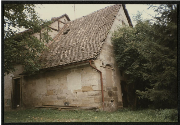
Dormitz, ehem. Synagogen-Anbau vor dem Abriss des baufälligen Ensembles im Jahr 2004 (Aufnahme 1986). Copyright Universitätsarchiv Bamberg, Forschungsstelle Landjudentum (Prof. Klaus Guth, Signatur 67/Dormitz/00001).
