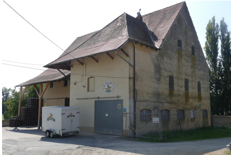
Buttenheim, ehem. Synagogengebäude. Vom ursprünglichen Bau sind nur noch die Reste von zwei Außenmauern erhalten (Aufnahme 2021). Copyright Wikimedia Commons / Nixnaxnobl
