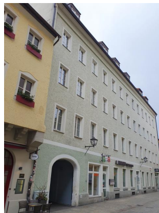
Regensburg, Gesandtenstraße 10, sog. "Judenhaus" in dem die NS-Machthaber jüdische Familien zwangseinquartierten, davor 2007 verlegte elf
