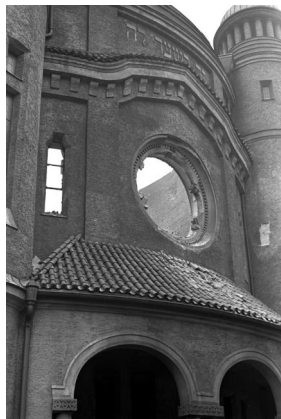
Die Zerstörungen vom 10. November 1938 an der Synagoge Regensburg (Schäffnerstraße 2 - heute: Am
