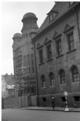
Der Abbruch der ausgebrannten Synagoge, 23. November 1938.
