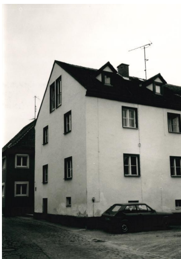
Das Gebäude der ehemaligen Synagoge nach dem Umbau zu einem Bürogebäude (Aufnahme 1987). Copyright Israel Schwierz, Würzburg
