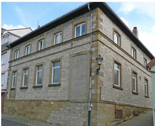
Nordwestansicht der ehem. Synagoge mit Spuren der Treppe und der Eingangstüre zur Männersynagoge (Aufnahme 2014) Copyright Axel Töllner, Neuendettelsau
