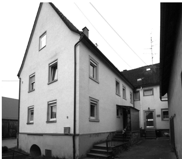
Tauberrettersheim, Ansicht von Nordwesten auf die ehem. Synagoge im Judenhof, dahinter jüdisches Wohnhaus (Aufnahme 2014). Copyright Cornelia Berger-Dittscheid, Maxhütte-Haidhof
