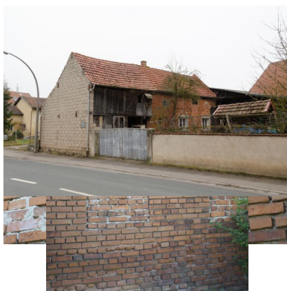
Zugemauertes Rundbogenfenster der ehemaligen Synagoge Kleinbardorf, 2012. Copyright Wikimedia Commons / Dietrich Krieger
