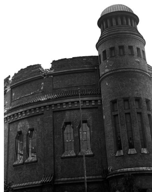
Die Zerstörungen vom 10. November 1938 an der Synagoge Regensburg (Schäffnerstraße 2 - heute: Am
