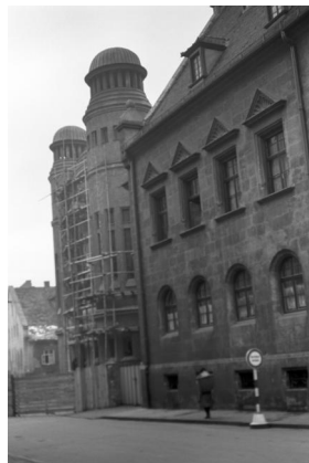
Der Abbruch der ausgebrannten Synagoge, 23. November 1938.
