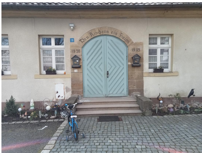
Eingangstür des ehemaligen Gebäudes der "Nathan u. Rosa Walter'schen Kinderstiftung" (Bahnhofstr. 18), Aufnahme 2022. Copyright Jürgen Hanke, Kronach
