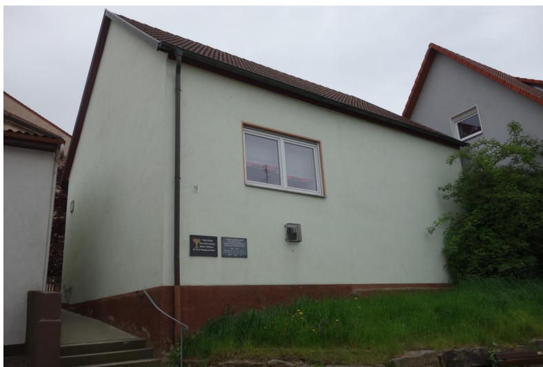
Oberthulba, Lederstraße 12, Nordseite der ehem. Synagoge (Aufnahme 2019). Copyright Cornelia Berger-Dittscheid, Maxhütte-Haidhof
