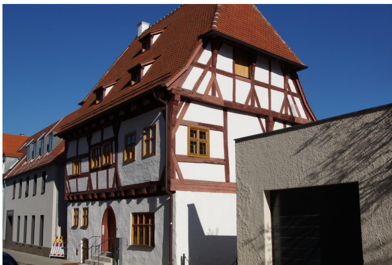
Ehemaliges Wohnhaus, sog. Schreiberhaus, Bräugasse 19, zweigeschossiger Halbwalmdachbau mit Fachwerkobergeschoss, 1430, mit Umbau 1610; Mikwe, jüdisches Ritualbad, um 1450. Copyright Wikimedia Commons / DALIBRI
