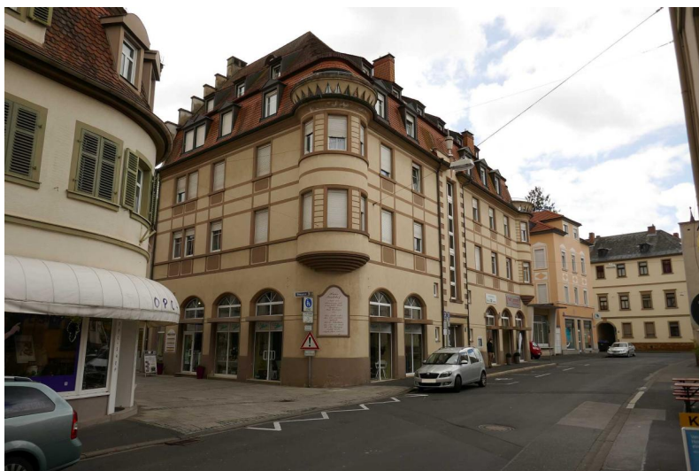
Standort der 1705 errichteten Synagoge in der Nähe des Erthal'schen Judenhofes, die 1851/1852 durch einen Neubau ("Alte Synagoge") ersetzt wurde. Der jetzige Gebäude (Saalehof) wurde 1928 neu errichtet. Copyright Peter Karl Müller, Bad Kissingen
