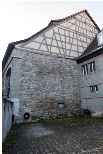
Auf dem Grundstück der ehemaligen Synagoge, die 1351 der Stadt übertragen wurde, errichtete das Augustinereremitenkloster ein Kelterhalle. Das Gebäude ist mit "1567" bezeichnet. Copyright Wikimedia Commons /Tilman2007
