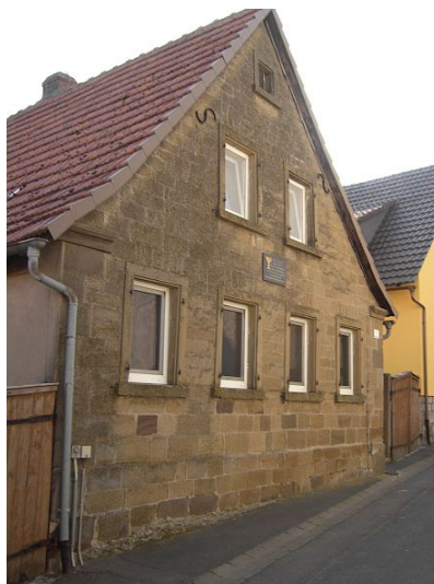
Gebäude der ehemaligen Synagoge Gnodstadt (Schulgartenweg 1) mit der zwischen den Fensterreihen angebrachten Gedenktafel. Copyright Alemannia Judaica
