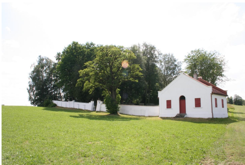
Jüdischer Friedhof, trapezförmige Anlage, von Mauern mit Stützfeilern eingefriedet, um 1628 angelegt und wohl 2. Hälfte 19. Jh. erweitert; Tahara-Haus von 1898. Copyright Wikimedia Commons / Krumbacher
