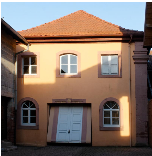
Ehemalige Synagoge Kleinheubach; Westfassade mit geöffneter Garagentor. Die Portalseiten und die Türflügel sind als Attrappe auf das Tor gemalt (Aufnahme 2011). Copyright Wikimedia Commons / E-W
