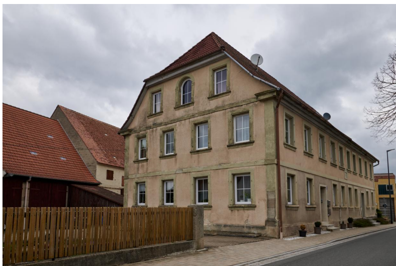
Das Gebäude in der Neustädter Straße 2-4 wurde im 19. Jahrhundert von jüdischen Familien bewohnt und trägt noch eine Bauinschrift von 1840. Copyright Wikimedia Commons / Tilman2007
