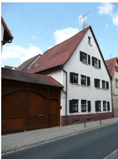
Ehem. jüdisches Gemeindehaus Breite Straße 53 (Aufnahme 2012). Im Hintergrund Dachfläche des Anbaus, in dem sich früher der Betsaal befand. Copyright Axel Töllner, Neuendettelsau
