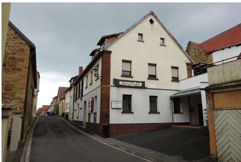
Gerolzhofen, Steingrabenstraße 51, ehem. Synagoge als Wohn- und Geschäftshaus (Aufnahme 2020). Copyright Cornelia Berger-Dittscheid, Maxhütte-Haidhof
