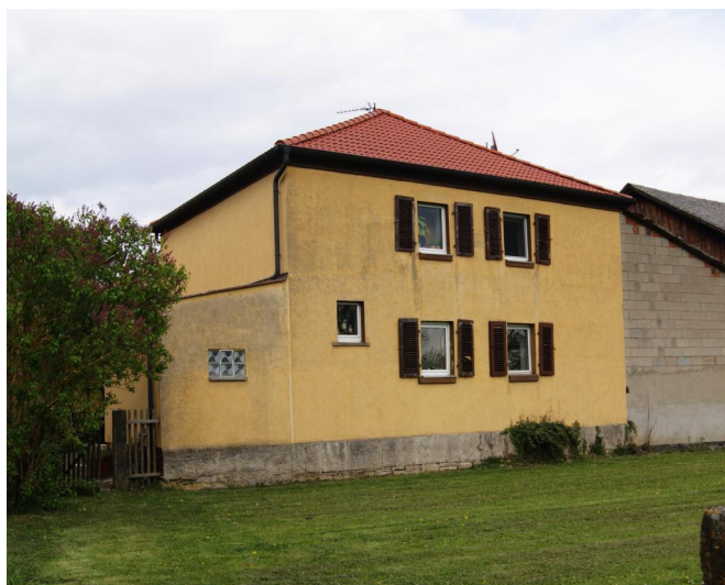
Geroldshausen, ehem. Synagoge vom Südwesten (Aufnahme 2014). Copyright Cornelia Berger-Dittscheid, Maxhütte-Haidhof
