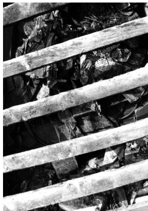
Nach dem Ankauf der Synagoge 1988 durch die Gemeinde Georgensgmünd fand sich der Restaurierung
