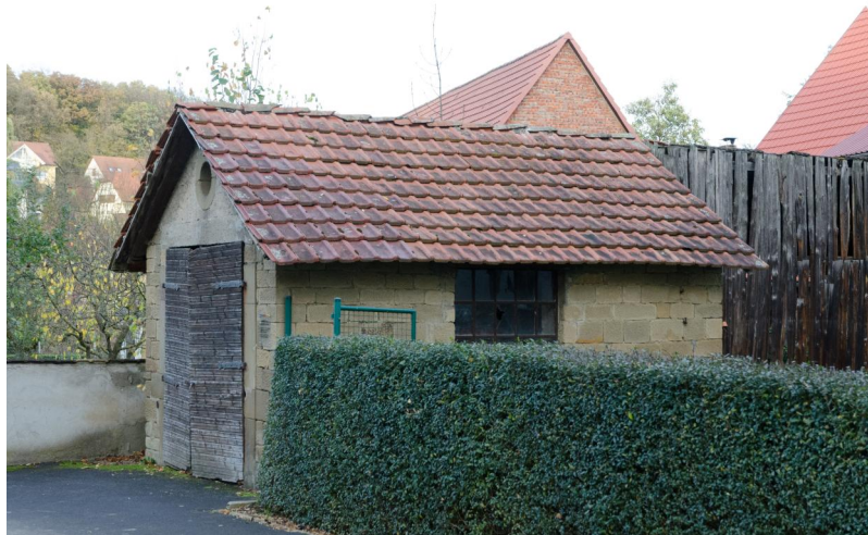
Kleines Gebäude für den Leichenwagen (Kirchgasse 11, neben dem ehemaligen Synagogengebäude). Auf dem Verbandsfriedhof wurden die Toten der Gemeinden Euerbach, Geldersheim, Kötzbach, Obbach, Niederwerrn und Schweinfurt (bis 1874) bestattet. Copyright Wikimedia Commons / Tilman2007
