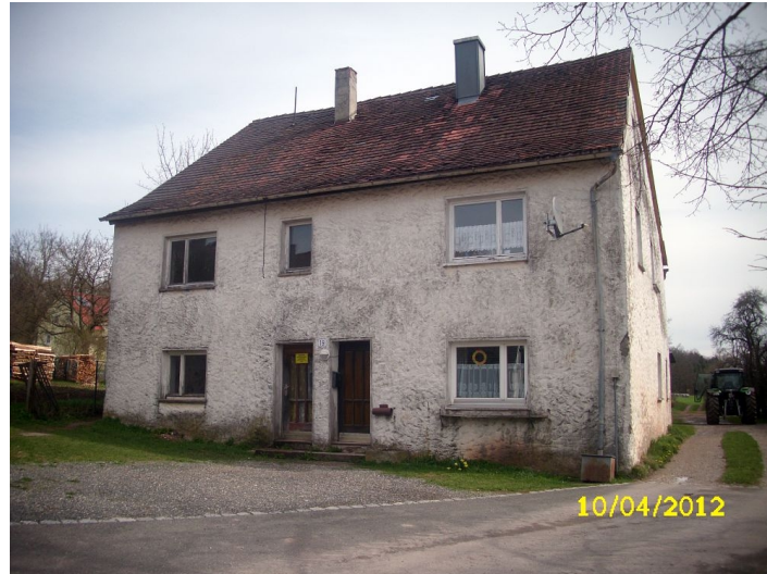
Das ehemalige Gemeindezentrum in Fürstenfeld mit Schule , Lehrerwohnung und Synagoge wird als Wohnhaus genutzt. Auf die frühere Nutzung weisen die beiden getrennten Eingänge hin.
