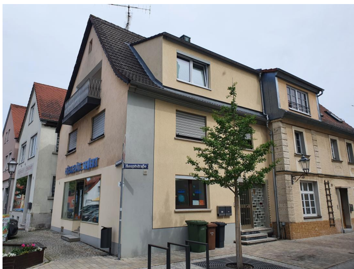
Burgebrach, ehem. Synagoge in der Hauptstraße 23 / Ecke Marktstraße (Aufnahme 2022). Copyright Haus der Bayerischen Geschichte / Foto: Patrick Charell
