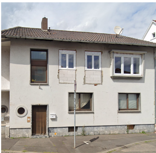
Mömlingen, Bachstraße 12, ehem. jüdisches Wohnhaus mit Betraum (Aufnahme 2023). Copyright Google Maps
