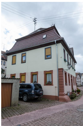
Ehemalige Synagoge, Fischergasse 32, zweigeschossiger Mansardwalmdachbau mit verputztem Fachwerkobergeschoss, bez. 1732. Copyright Wikimedia Commons / Tilman2007
