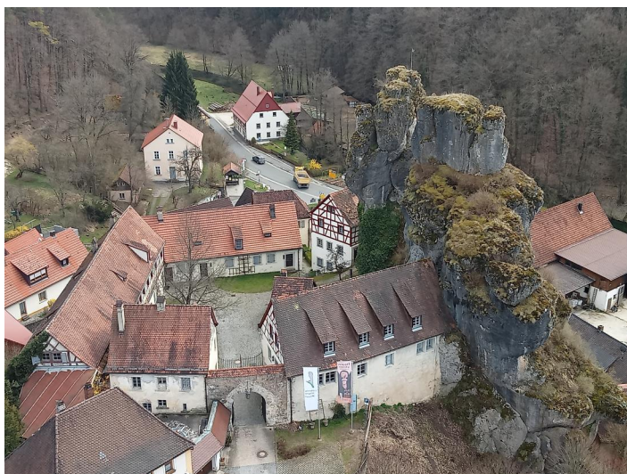
Blick vom Zeckenstein auf das Gebäudeensemble "Judenhof", heute Fränkische Schweiz-Museum, mit der ehemaligen Synagoge. Copyright Jürgen Hanke, Kronach
