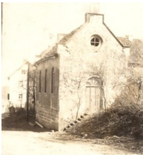
Synagoge Eichenhausen, 1925. Copyright Sammlung Reinhold Albert, Sulzdorf an der Lederhecke
